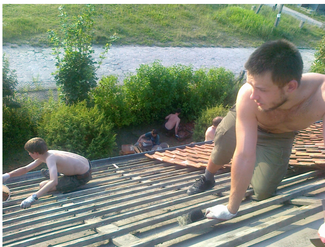
Obóz rowerowy Szczepu „Watra” z Zalesia Górnego, Bisztynek, 2012. Uczestnicy obozu pomagają naprawiać dach po zniszczeniach spowodowanych gradobiciem. Fot. J. Kamiński
