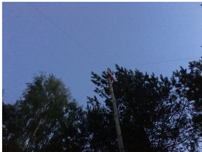
Ostatnia ciekawostka - maszt nastawny na odciągach, bez wkopywania w ziemię
