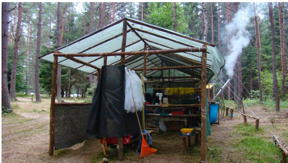
Zdjęcie 4 – Widok od obieralni. Fot. D. Listkiewicz Z lewej strony odciągów dachowym nie ma. Z prawej: przymocowane do płotków.
